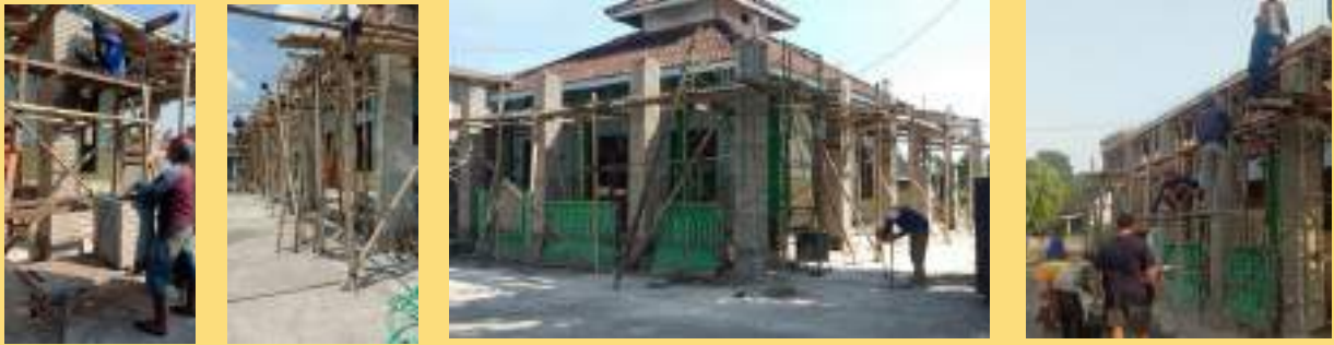
Dukungan untuk pembangunan/renovasi rumah ibadah di Desa Gayam Kabupaten Kediri
